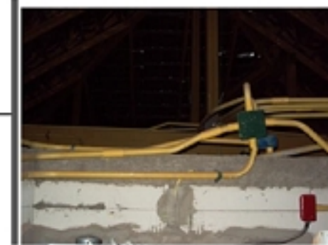
ร้อยสายไฟภายในท่อเหนือฝ้า
